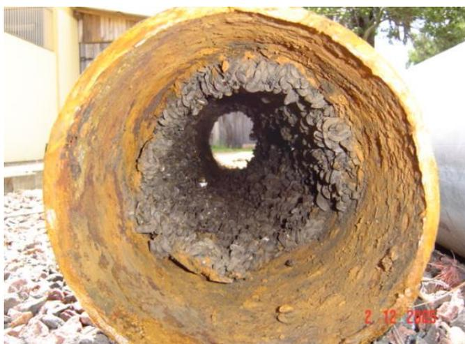
**Figura 3.8** - Tubulação infestada. (Foto: Corsan 2006)
