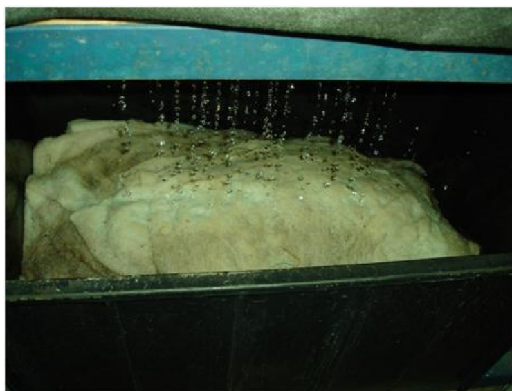
Figura 4.5 – Filtro biológico do sistema de manutenção
