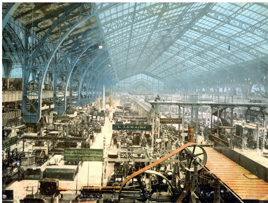
Figura 51 - Galerie des Machines – 1889.
