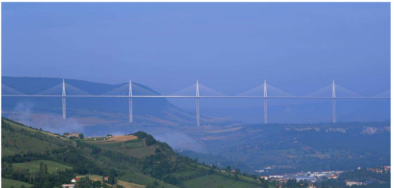
Figura 66 - Viaduto Millau, França. Fonte: http://www.fosterandpartners.com/
