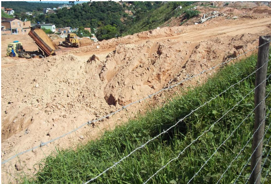
Figura nº 9 Aplicações de resíduo da construção civil e demolição em aterro para correção de nível e execução de drenagem para água pluvial.
