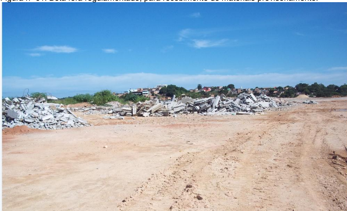
Figura nº 01: Bota fora regulamentado, para recebimento de materiais provisoriamente.
