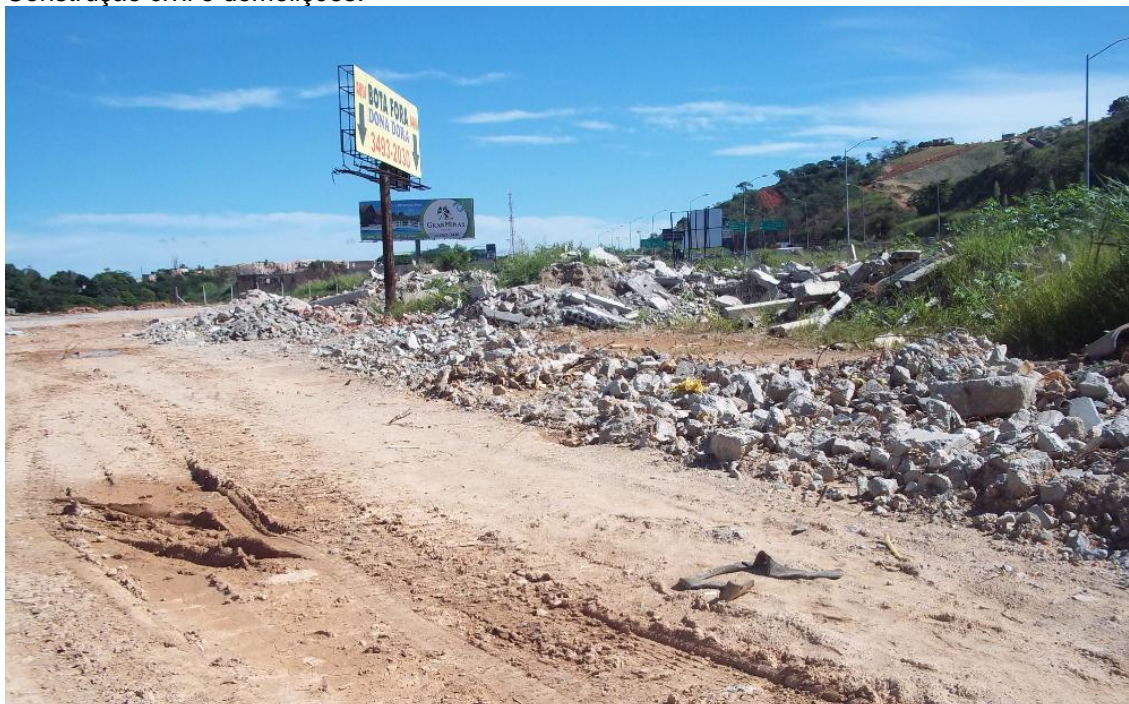
Figura nº 8: Bota-fora regulamentado de disposição provisória de resíduos da Construção civil e demolições.
