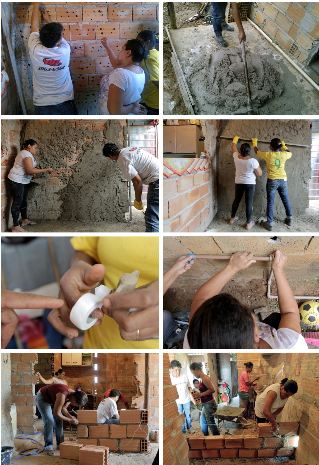
FIGURA 18 - Fotos Oficina de Construção
