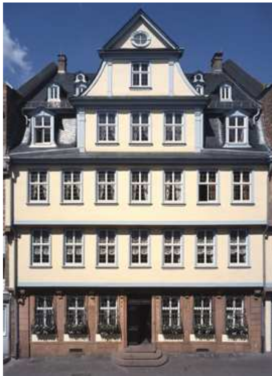
FIGURA 2.7: Goetheshaus em Frankfurt
