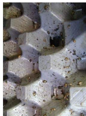
(B) Infestação de caramujos vista durante o P2 principalmente no compartimento inferior (4,20 m) do FBP
