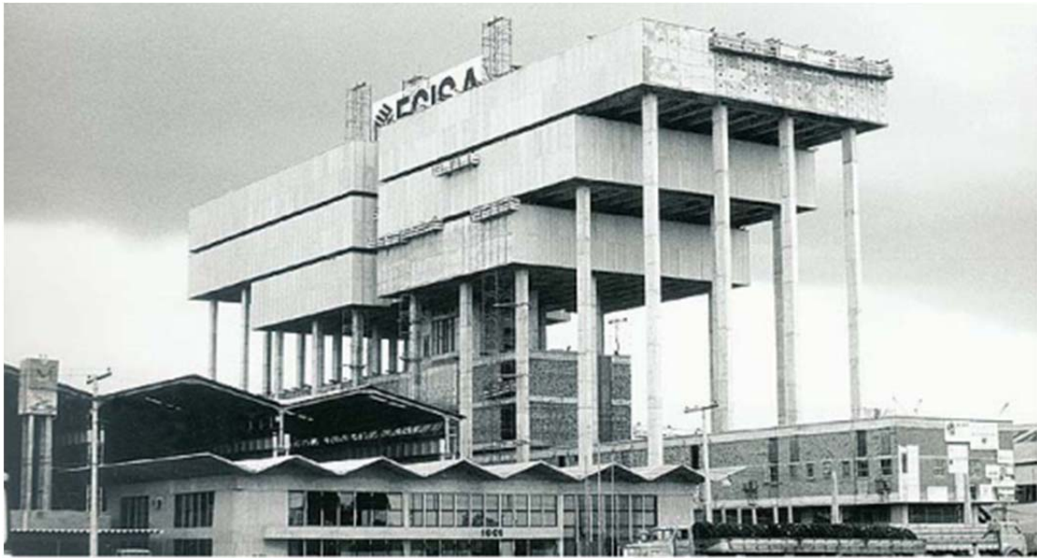
Figura 1.2 - Aplicação de pilares esbeltos (Macgregor, 1997).
