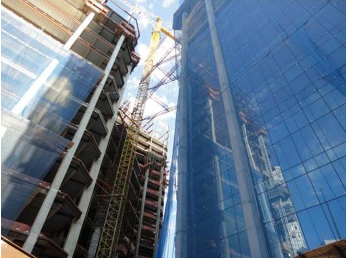
Figura 1.1 - Diversas etapas da construção de uma edificação com estruturas mistas.
