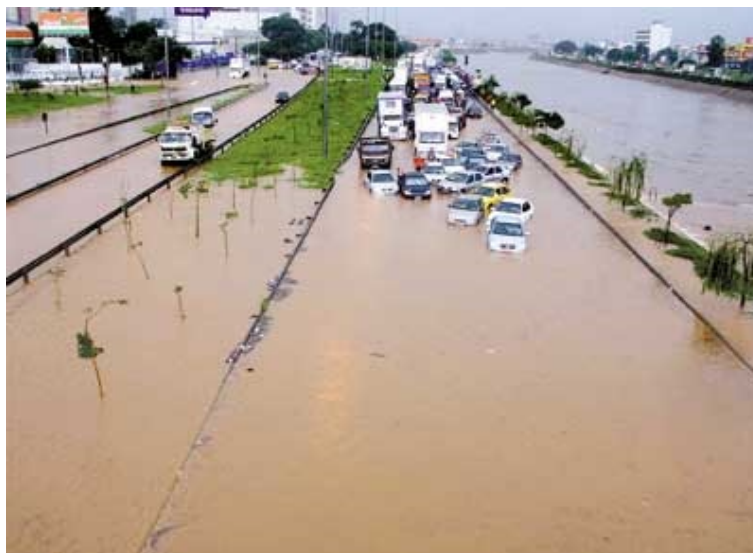
Figura 2.5: Inundação ocorrida nas margens do Rio Tietê, São Paulo 2012 Fonte: G1 (2012)
