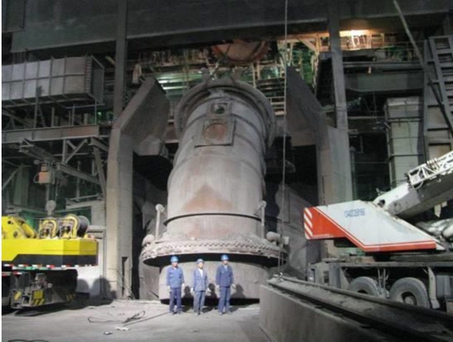
Figura 3-2: Coifa de captação dos gases de saída do convertedor LD
