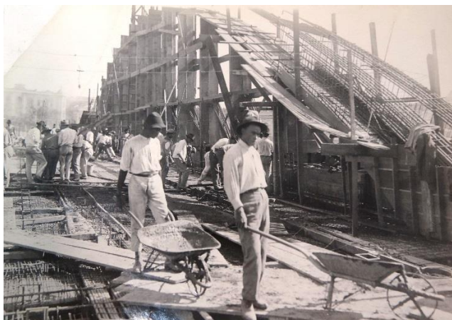
FIGURA 1 – Viaduto Santa Tereza em construção em 1928 Fonte: Arquivo Público da Cidade de Belo Horizonte - APCBH/Doação.
