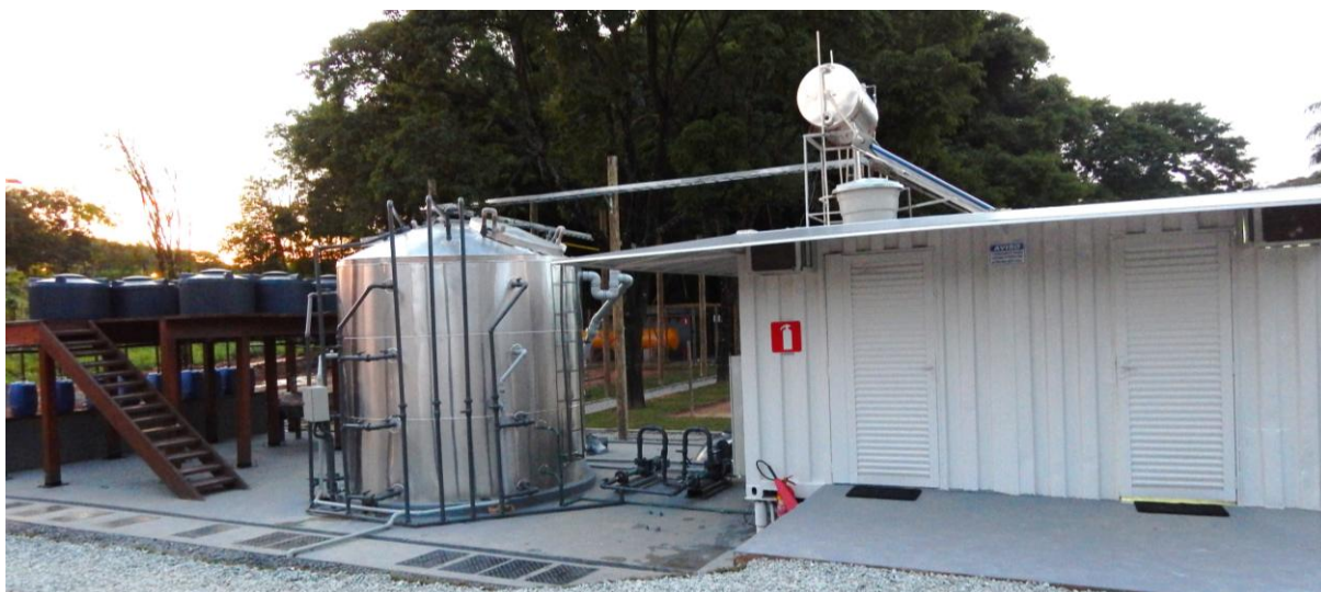
Figura 5.1 – Vista geral da plataforma pMethar, recentemente implantada no Quarteirão 10 do câmpus Pampulha (ao centro o biodigestor anaeróbio)
