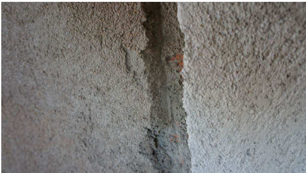
Figura 4.7 – Detalhe da espessura do revestimento argamassado, cerca de 2,5cm.
