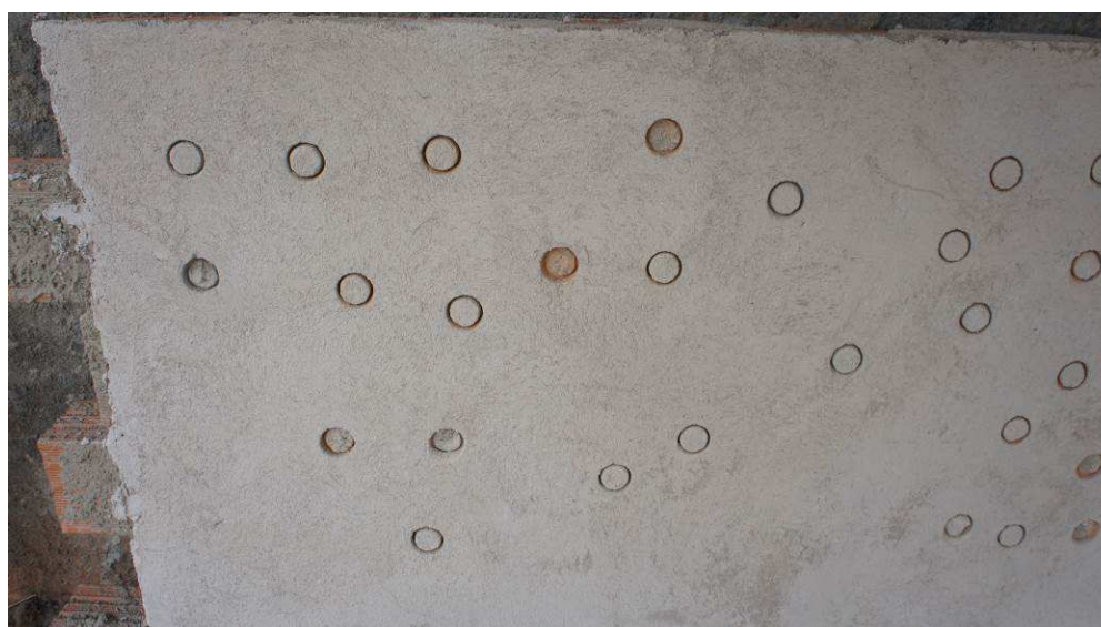
Figura 4.15 – Painel de argamassa preparado para os ensaios de resistência de aderência à tração.
