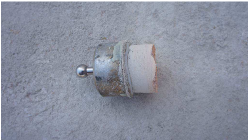
Figura 4.20 – Detalhe do corpo de prova arrancado no ensaio de resistência de aderência à tração no painel 3 de argamassa.
