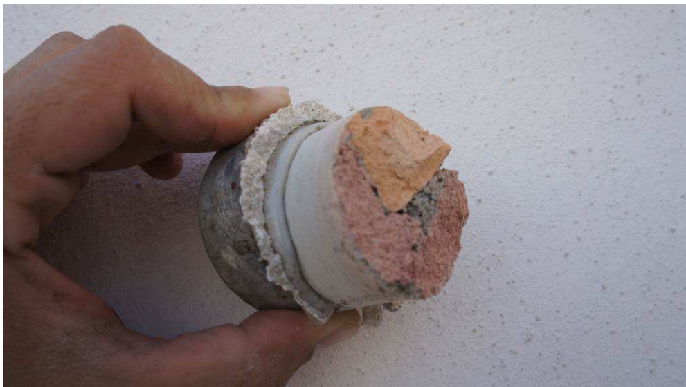
Figura 4.22 – Detalhe do corpo de prova arrancado no ensaio de resistência de aderência à tração no painel 3 de argamassa
