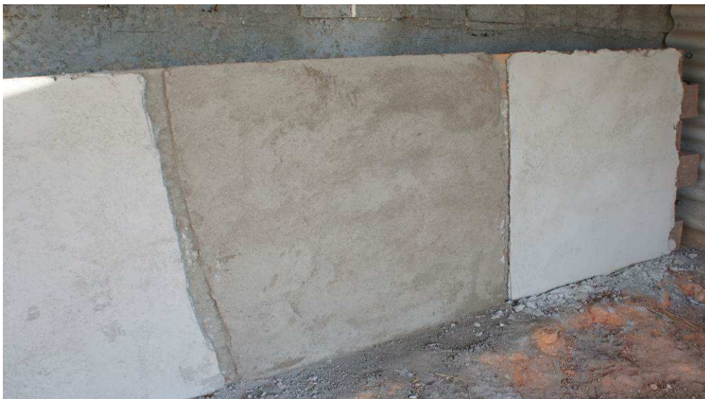
Figura 4.6 – Detalhe do painel subdividido e com argamassa de revestimento.
