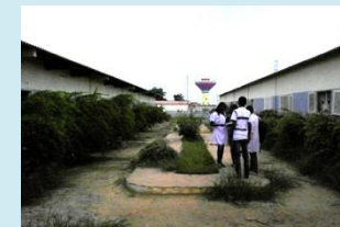
Pavilhão C, vista da casa de banho ao exterior.
