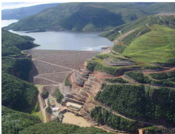
FIGURA 4.6 – Usina Hidrelétrica de Irapé
