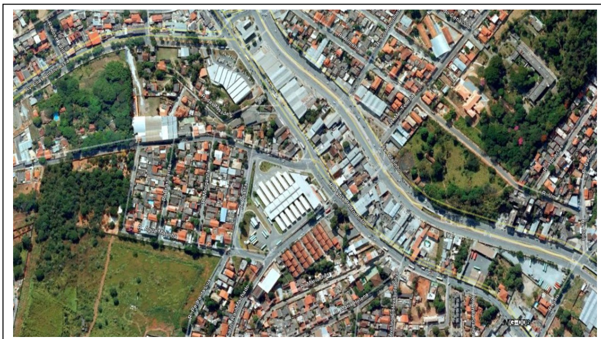
FIGURA 36 - Vista aérea da localização da Estação Venda Nova Fonte: TECNOTRAN; OFICINA, 2012.
