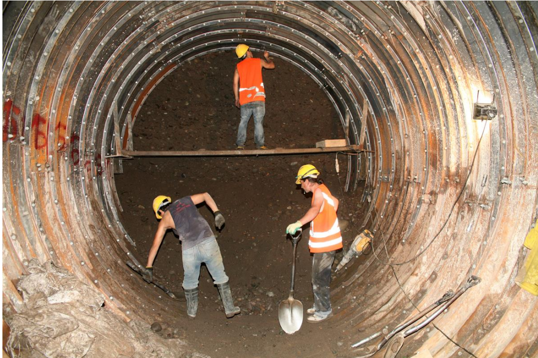
FIGURA 2.4 - Método de escavação “Tunnel Liner” (cintac 2014)
