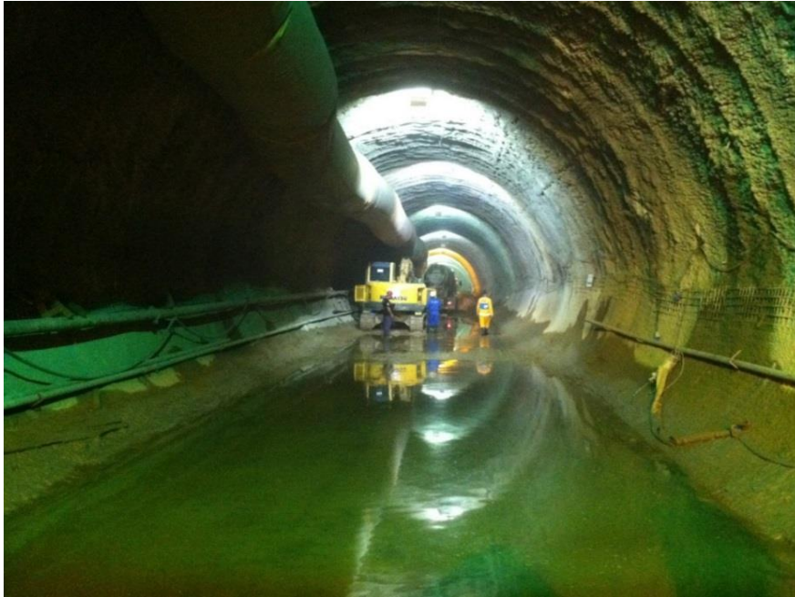
FIGURA 4.11 - Túnel de Desvio do Rio Joana, próximo ao emboque do poço “A”
