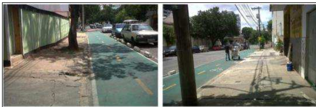
Figura 45 – Árvore ocupa parte da calçada.
