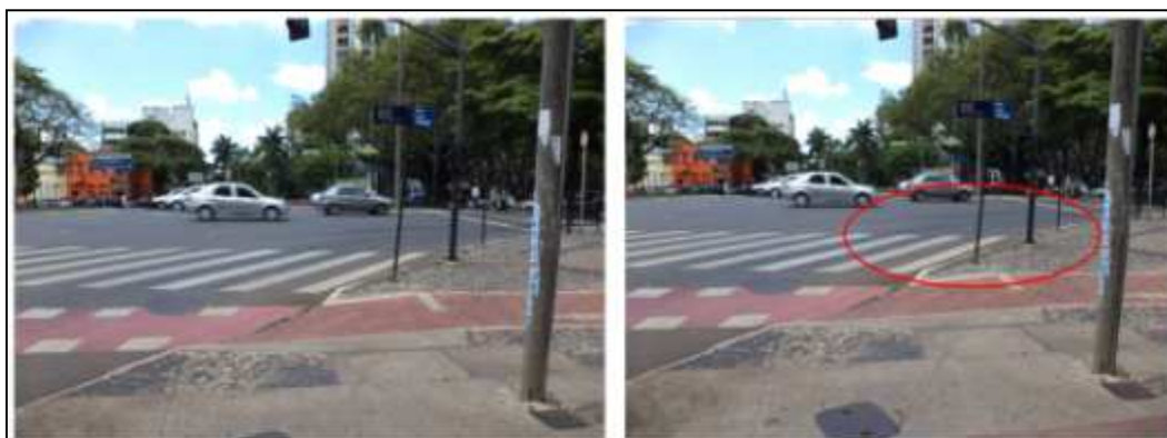
Figura 47 - Um semáforo obstrui parcialmente o acesso à faixa de pedestres.
