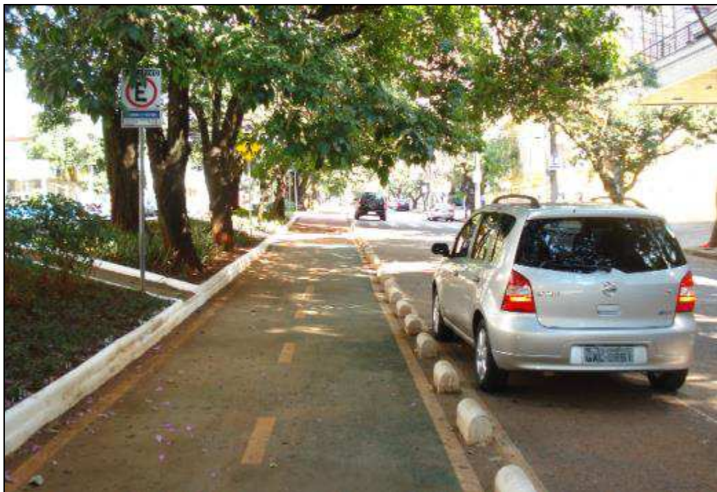
Figura 5 – Ciclovias com bloco separador em concreto, Belo Horizonte, 2012.
