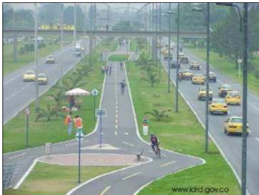
Figura 3 – Ciclovia no canteiro central, Bogotá.
