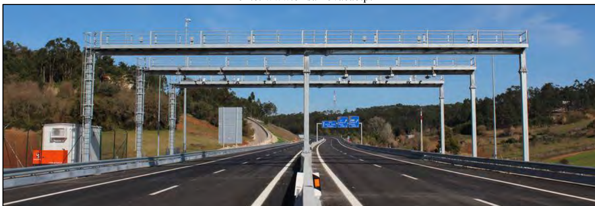
Figura 9 – Exemplo de pórtico de cobrança de pedágio em uma sistema de RPA
