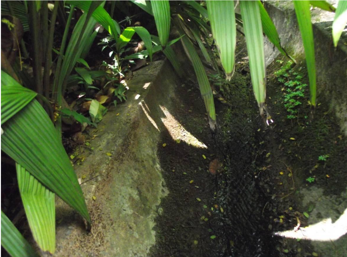
Figura 17: Calhas cimentadas no parque municipal Julien Rien, Belo Horizonte, Minas Gerais.
