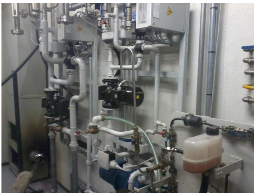
Figura 3.8 – Partes do sistema de condicionamento de temperatura do fluido de arrefecimento e lubrificação do motor.
