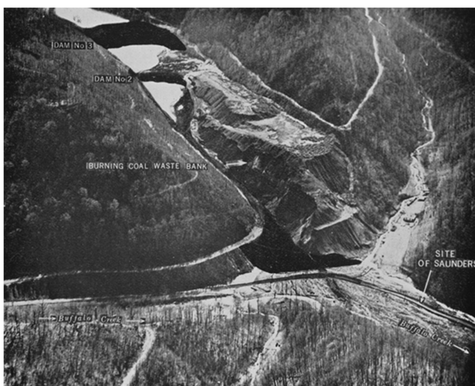
FIGURA 3.8 – Configuração da barragem de rejeitos no vale do córrego Middle, afluente do rio Buffalo, antes do acidente
