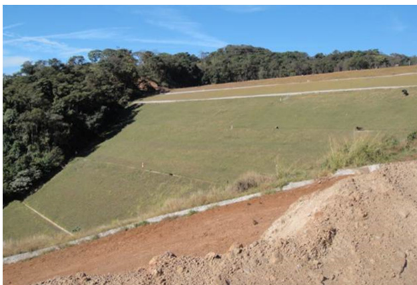
FIGURA 4.3 – Fotografia do talude de jusante da Barragem Tico-Tico
