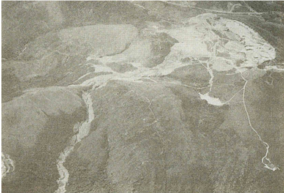
FIGURA 3.15 – Vista aérea da barragem de Fernandinho e do talvegue a jusante após a ruptura
