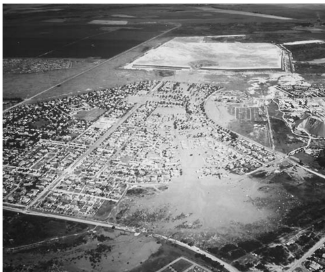
FIGURA 3.16 – Vista aérea da inundação provocada pela ruptura da barragem Merriespruit Fonte: BLIGHT, 2010
