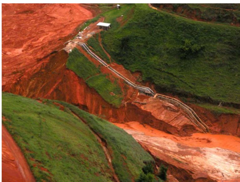
FIGURA 3.18 – Perspectiva da brecha na barragem São Francisco
