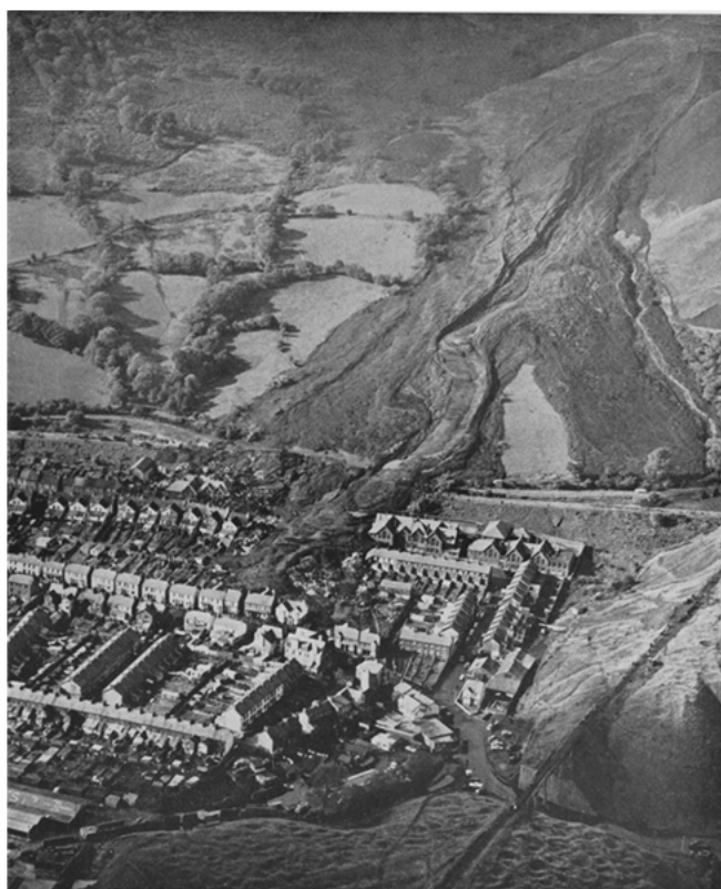
FIGURA 3.7 – Vista aérea do fluxo de rejeitos após o acidente em Aberfan Fonte: BISHOP, 1973
