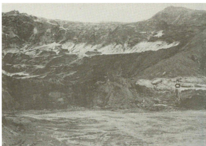
FIGURA 3.14 – Cicatriz deixada pela ruptura da Barragem de Fernandinho
