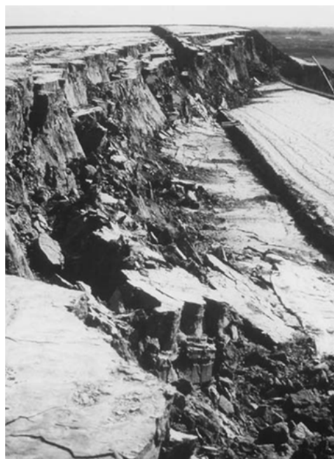
FIGURA 3.10 – Detalhe da cunha de ruptura em Bafokeng
