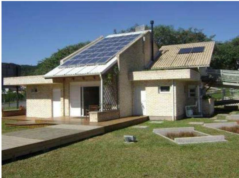
Figura 2.7 – Exemplo de casa com microgeração solar fotovoltaica
