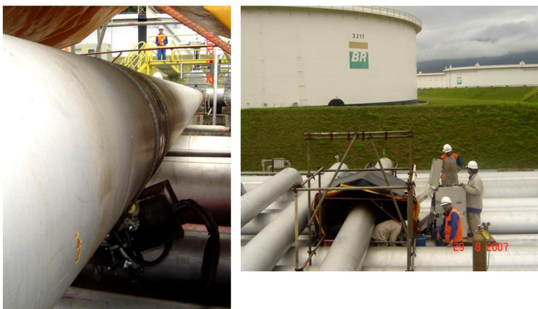
Figura 2.20: Soldagem utilizando equipamento robotizado.
