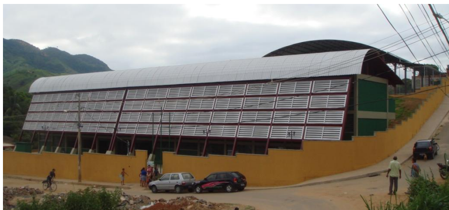
Figura 6: Escola Padrão 3 Pavimentos, E.E. Jardim Ipê, Governador Valadares, MG Fonte: DEOP/MG – outubro/2012
