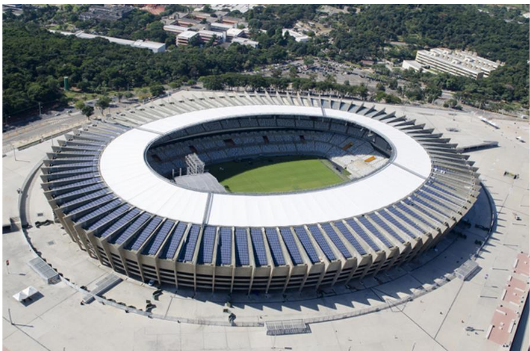
Figura 6 Usina Solar Fotovoltaica do Mineirão. Fonte: CEMIG DISTRIBUIÇÃO
