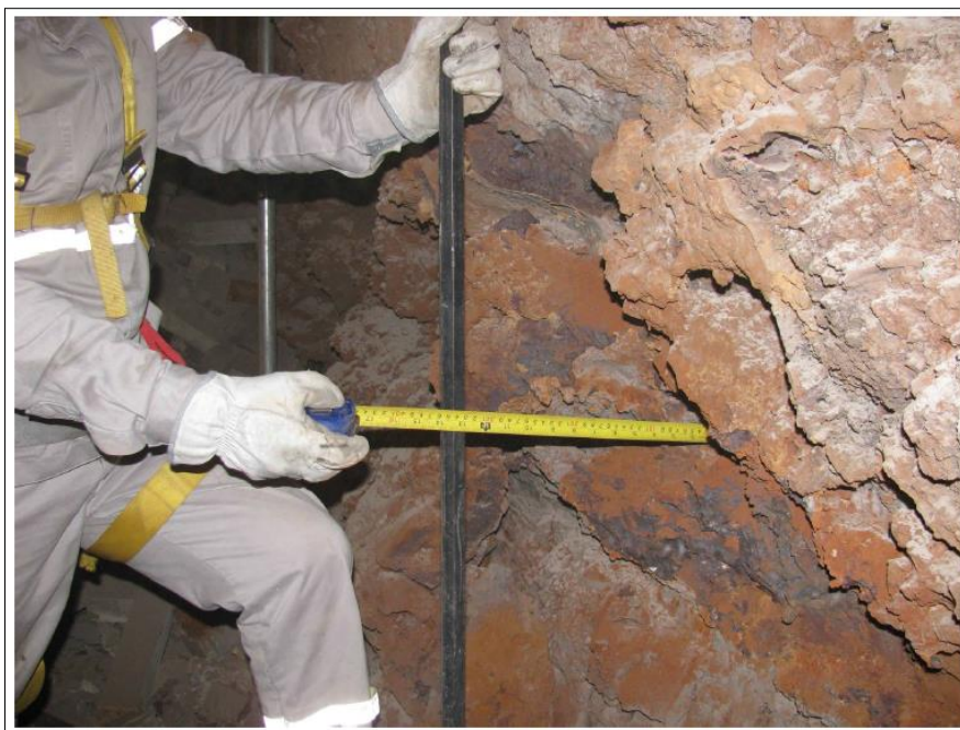
Figura 23 – O desgaste encontrado pela equipe de demolição
