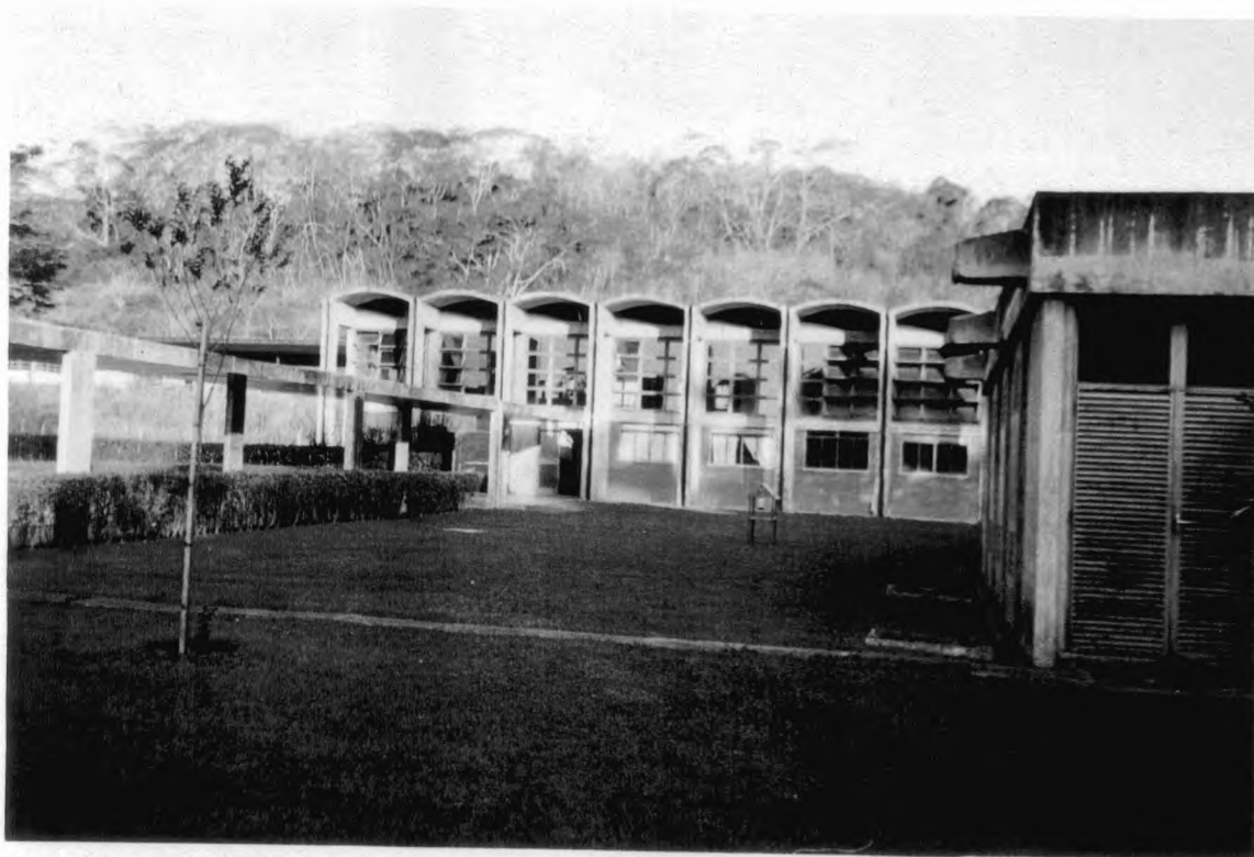
FIGURA 11 - Vista parcial das futuras instalações da Incubadora de Empresas da FUNARBE/UFV
