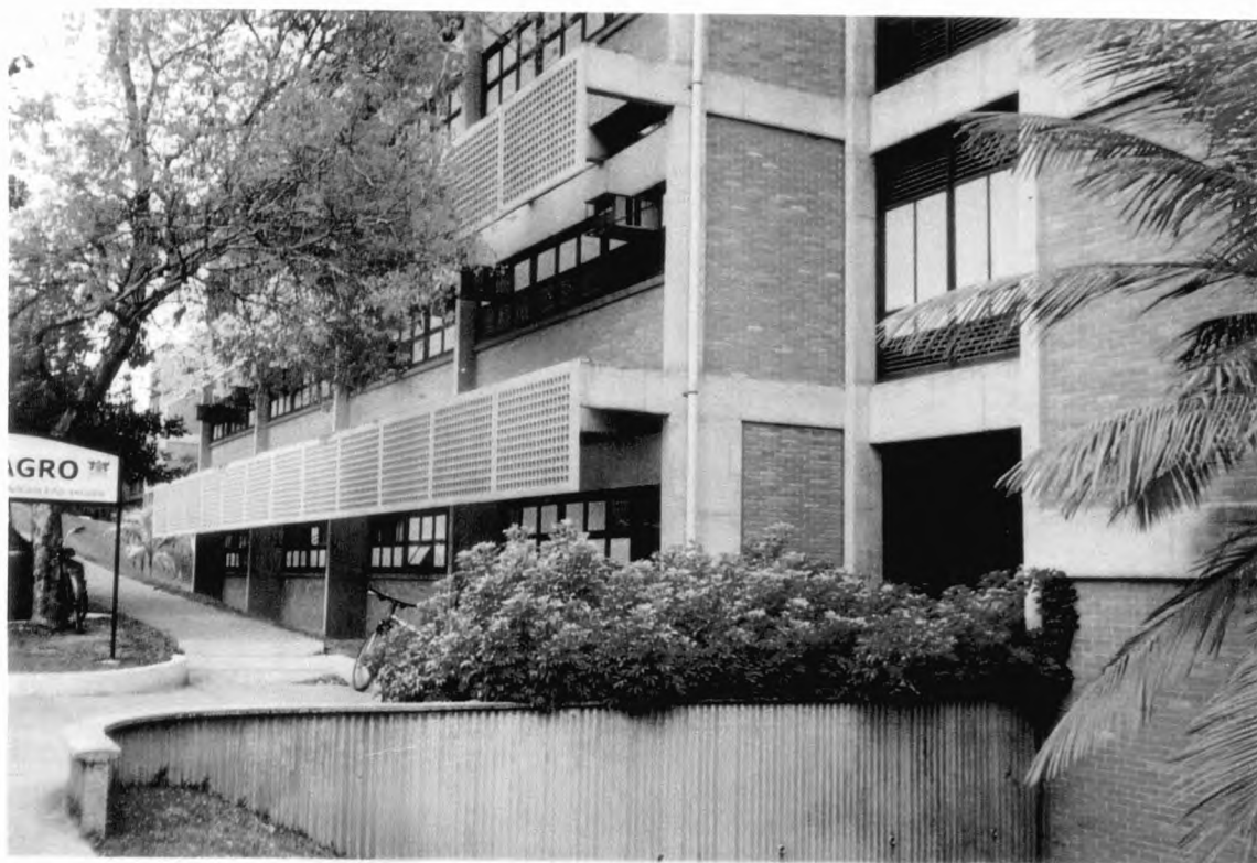
FIGURA 10 - Vista parcial do Centro de Pesquisa onde está situada a Empresa Incubada 5 - FUNARBE/UFV
