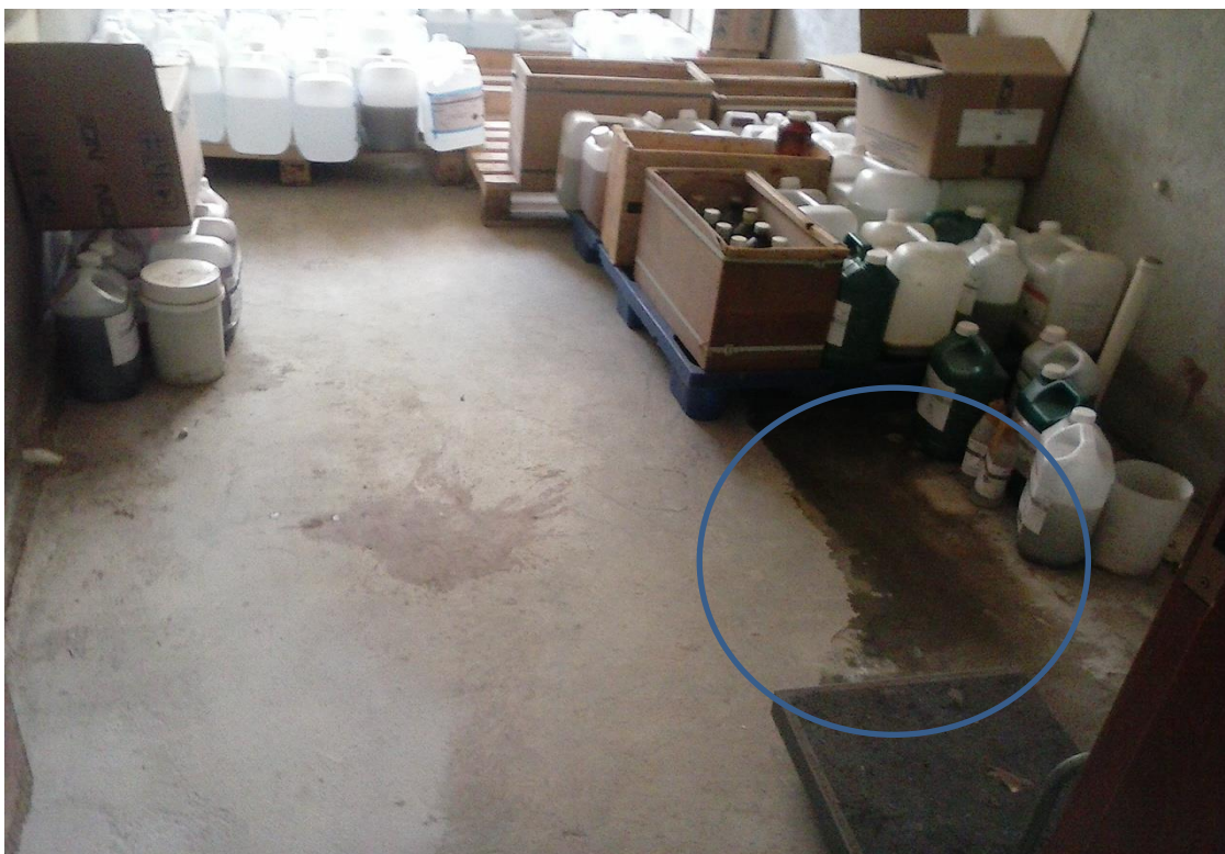
Fotos 07 e 08: Abrigo de resíduos químico perigosos sem condições de segurança, com sinais de derramamento de produto químico, improvisados e com espaço insuficiente.
