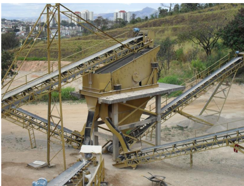
FOTO 9: Deck de peneiras da usina de reciclagem da BR 040.
