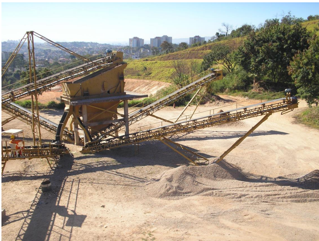
FOTO 3: Vista geral da usina de reciclagem da BR 040 em Belo Horizonte.
