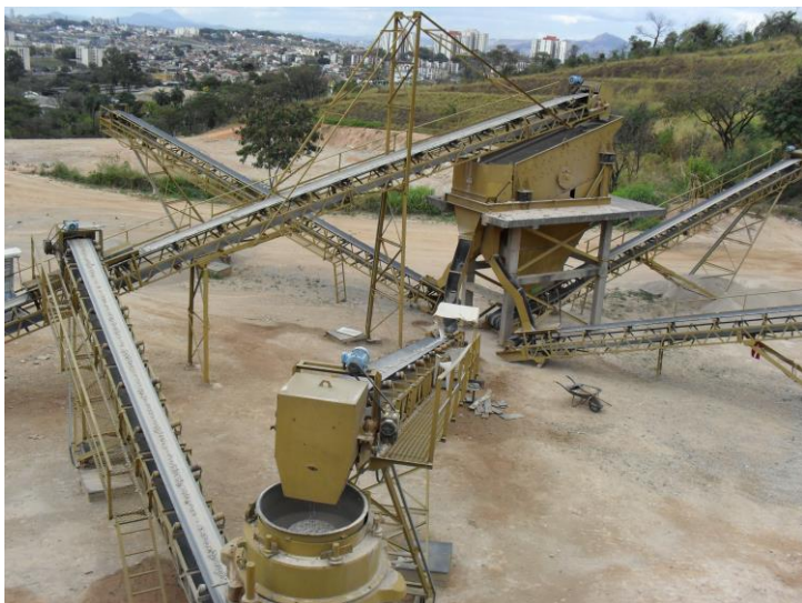
FOTO 8: Transportadores de correia da usina de reciclagem da BR 040.
