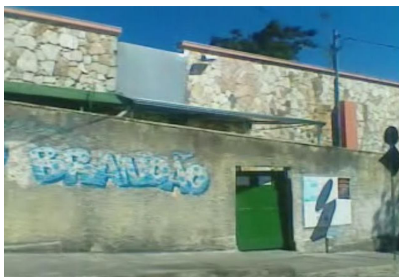
FIGURA 1: Foto da fachada da Escola Professor Cláudio Brandão
