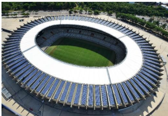
Figura 23. Vista superior da UFV montada na cobertura do estádio Mineirão.
