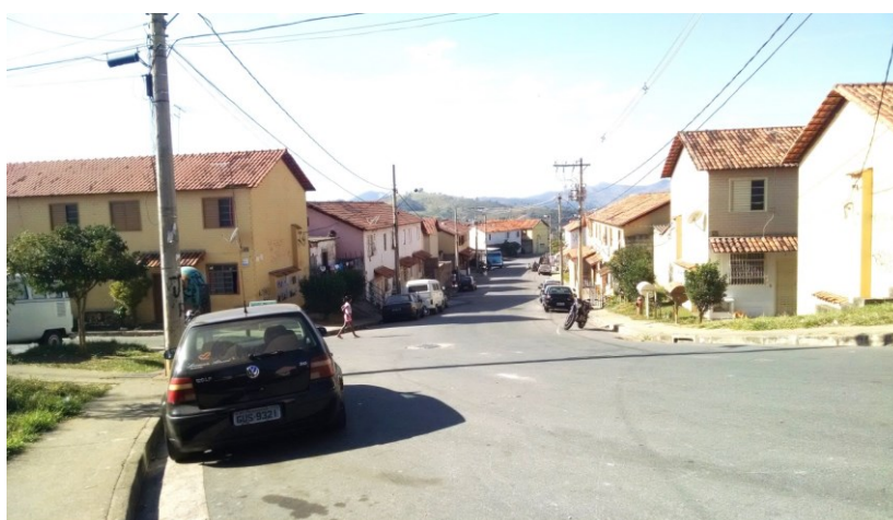
Foto 3 - Conjunto Granja de Freitas III: coberturas e blocos habitacionais
