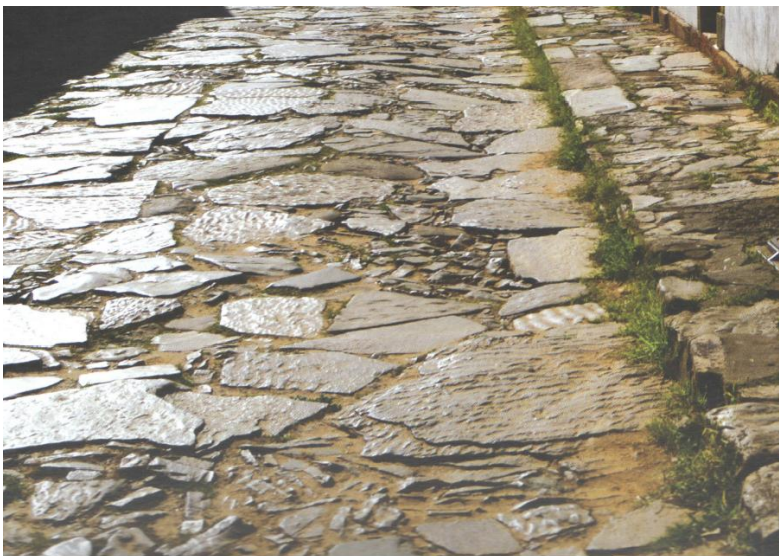
Figura 12 – Atual calçamento da Rua Direita. Autoria: Desconhecida. Fonte: Antônio da Cruz (2015).
