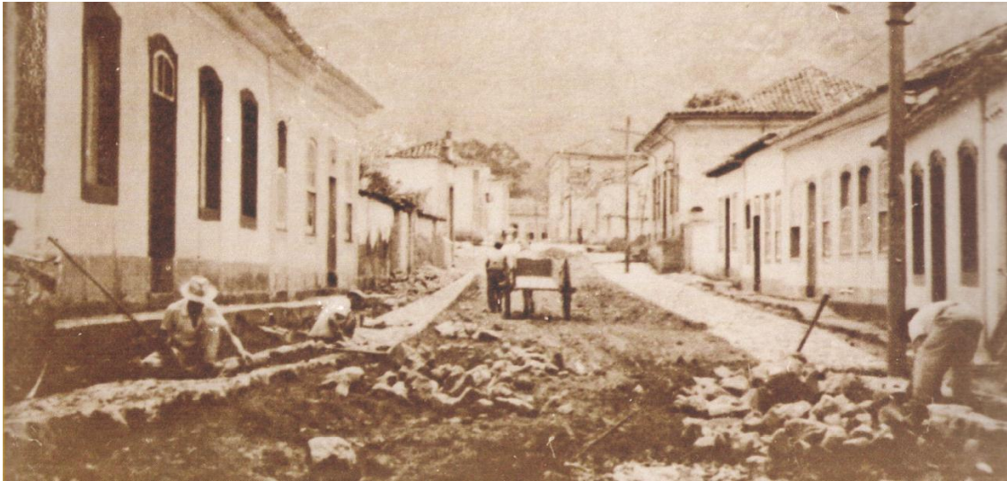
Figura 11 – Obras de execução do calçamento da Rua Direita, entre 1959 e 1963. Autoria: Desconhecida. Fonte: Acervo Maria José Moura Nascimento, recuperado de Santos Filho (2015).
