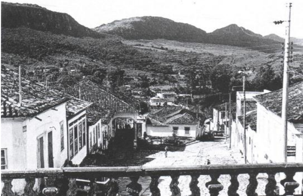
Figura 13 – Antiga iluminação substituída em 1984.
