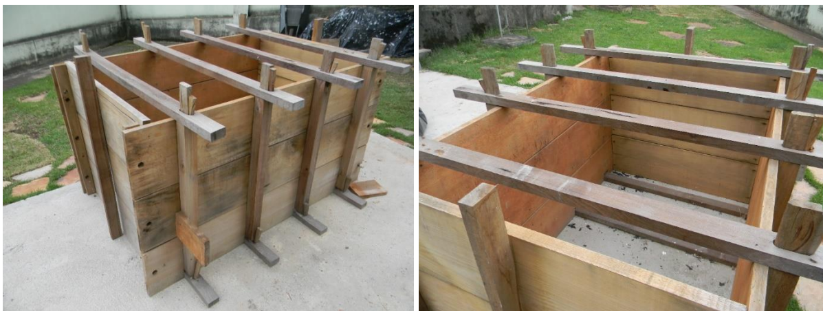
Figuras 88 e 89: Taipal utilizado na compactação da miniparede em taipa de pilão
