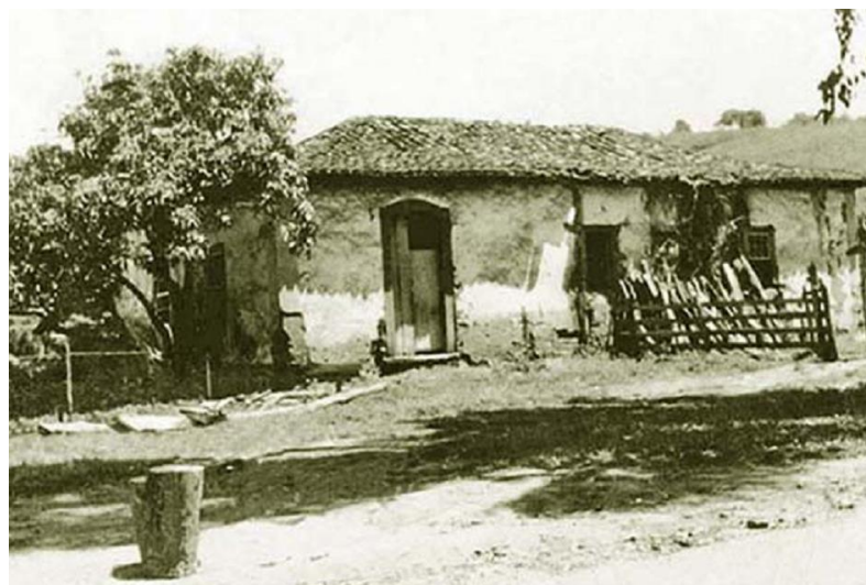
Figura 20: Casa de taipa de pilão em Baependi – arruinada, restando apenas registros fotográficos
