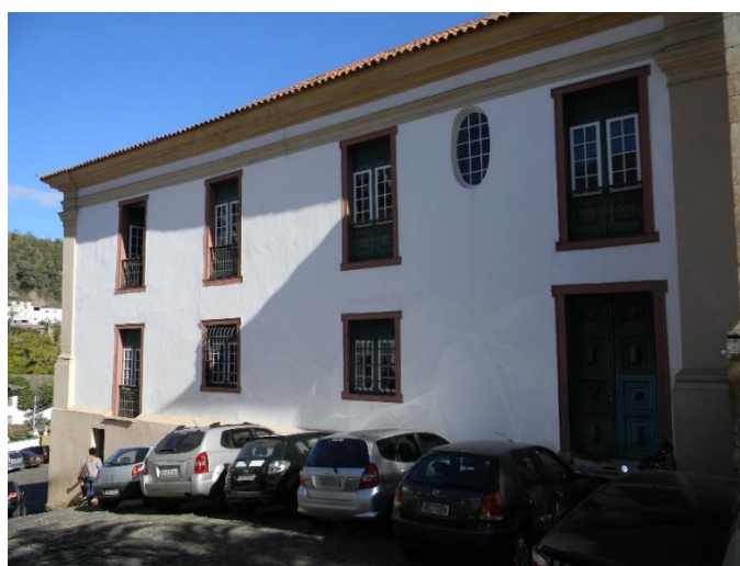
Figura 66: Igreja Matriz Nossa Senhora do Pilar
