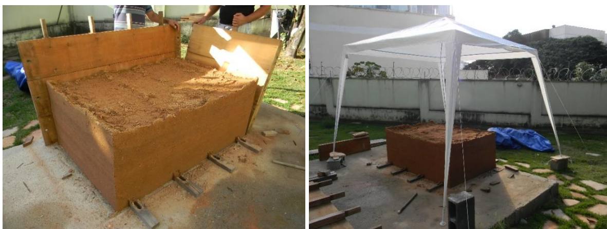
Figuras 99 e 100: Retirada da forma da miniparede
