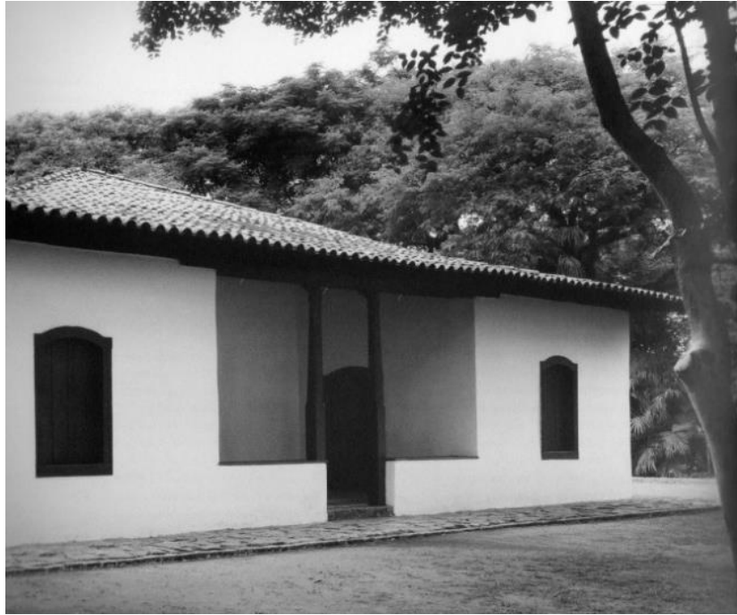
Figura 02: Casa do Butantã, S.P.
