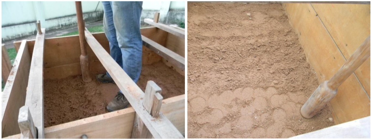
Figuras 95 e 96: Compactação da miniparede.
