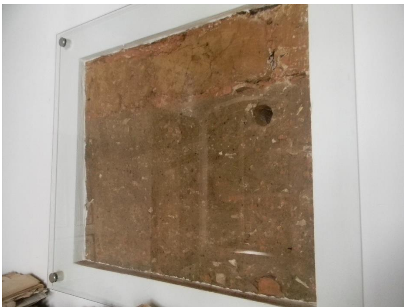
Figura 60: Sobrado próximo à Igreja de São José Fonte: Acervo da autora, 2015.
