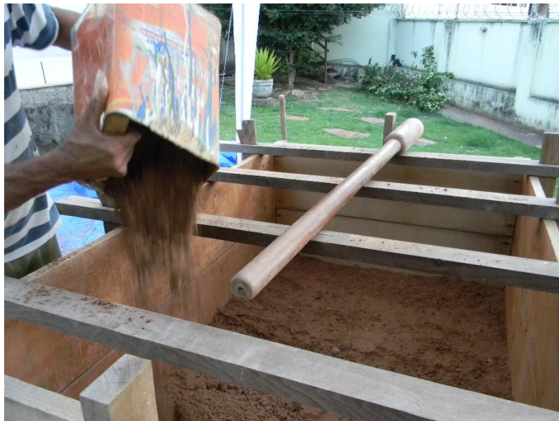
Figura 17: Taipal e pilão empregados na construção da miniparede
