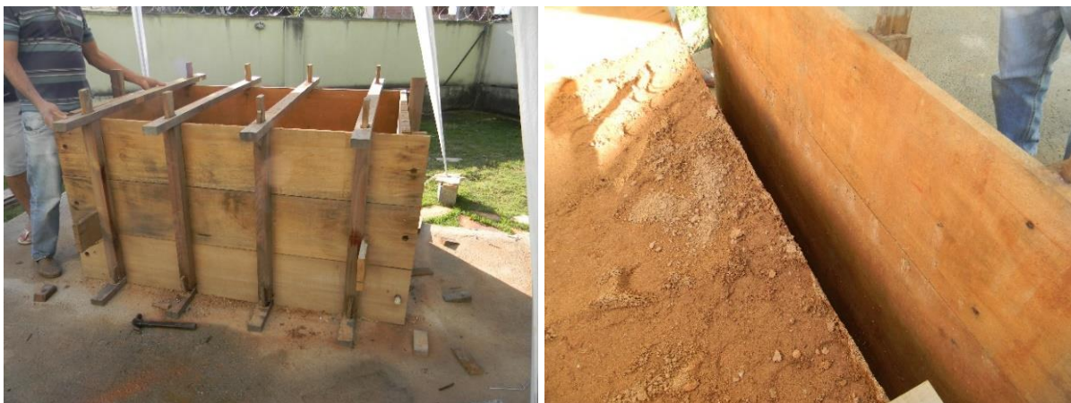
Figuras 97 e 98: Retirada da forma da miniparede
