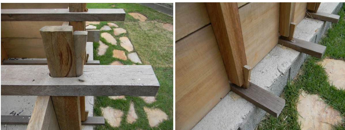
Figuras 90 e 91: Detalhe das cunhas do taipa utilizado na compactação da miniparede em taipa de pilão
