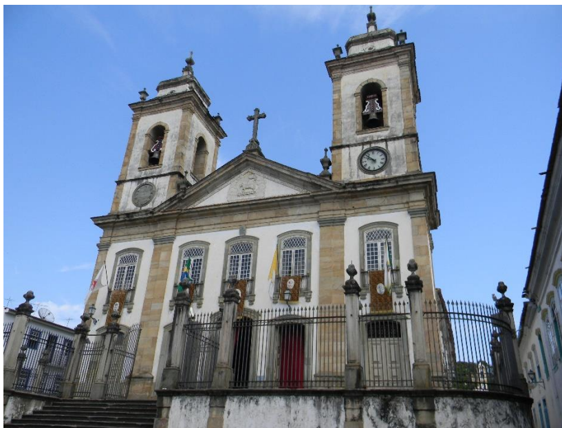
Figura 75: Igreja Matriz Nossa Senhora do Pilar
