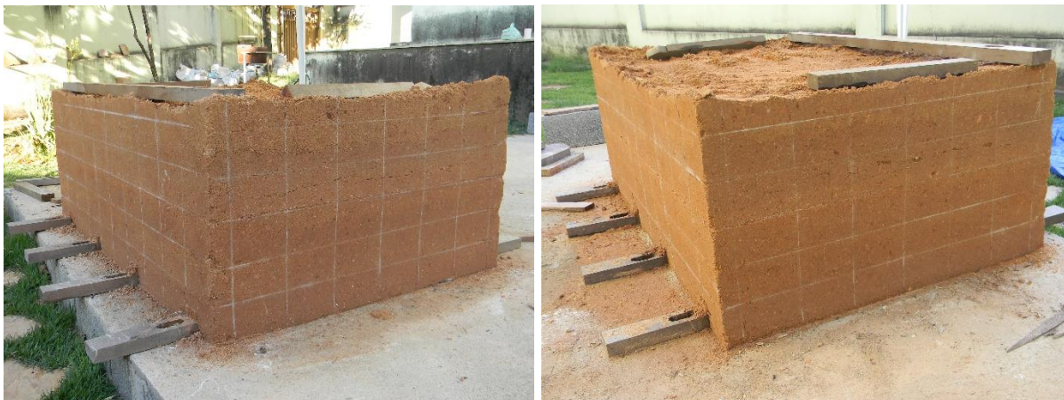
Figuras 101 e 102: Malha e pontos de medição
