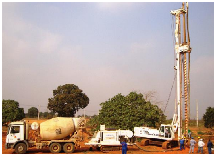
Imagem 2 – Concretagem Fonte: http://www.geofund.com.br
