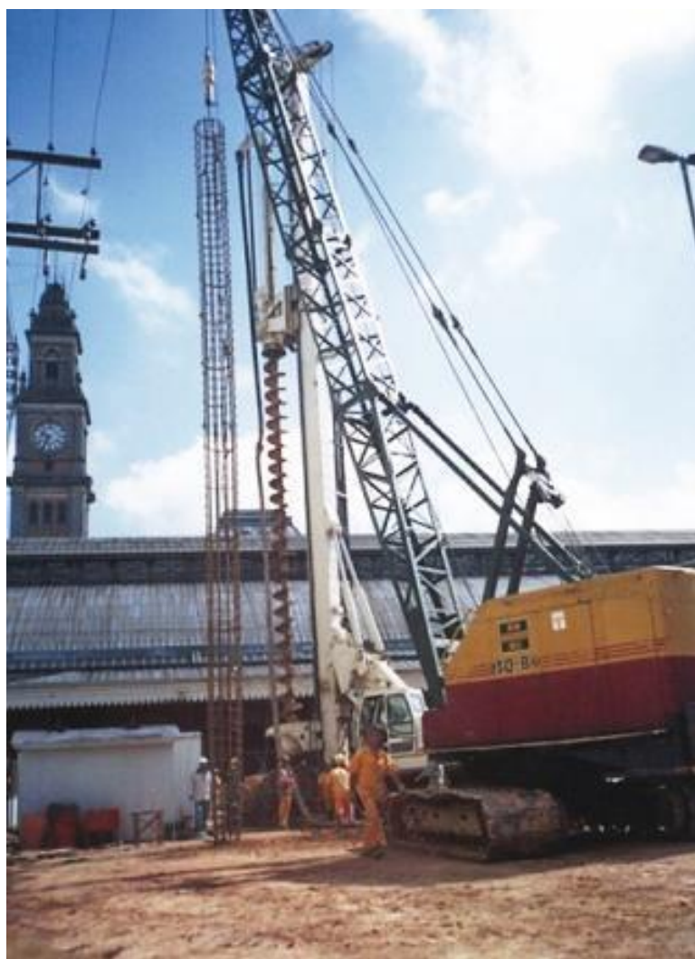
Imagem 3 – Colocação da armadura Fonte: http://www.fundesp.com.br
