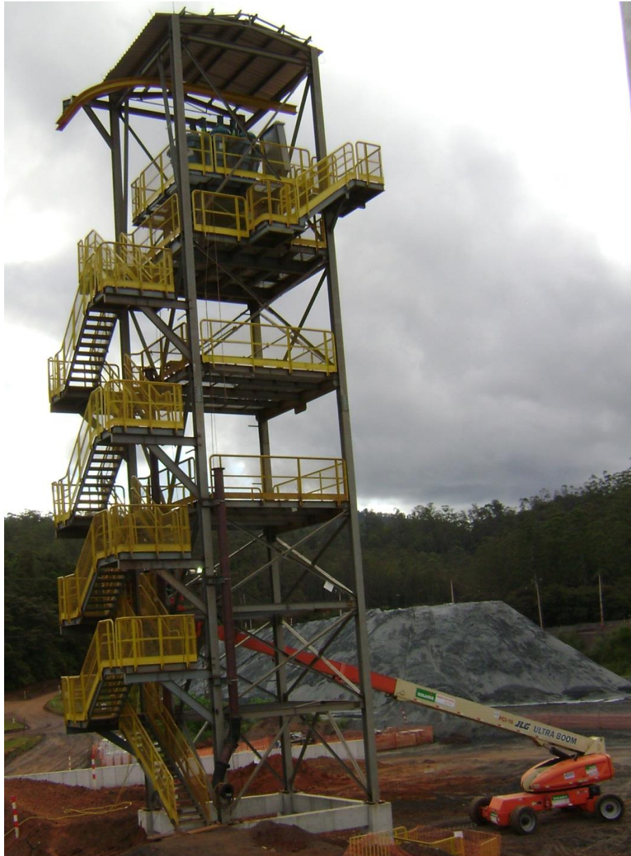
Imagem 5 – Foto do prédio do Hidrociclone concluído – Fonte: Arquivo particular.
