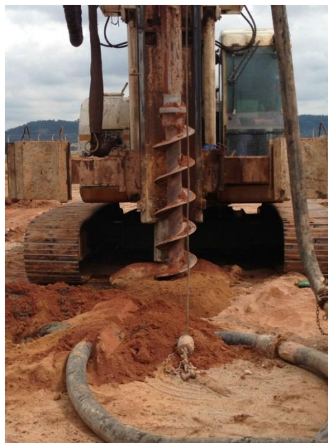
Imagem 1 – Perfuração Fonte: http://ambienteconstrucao.com.br
