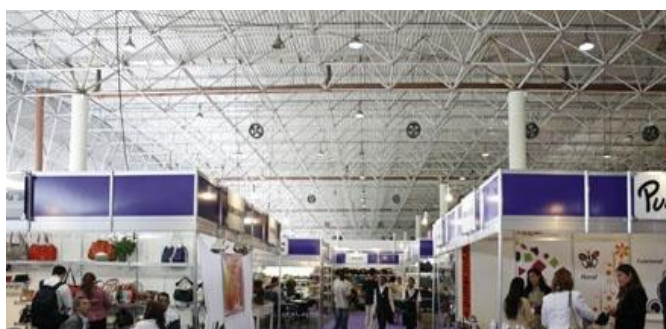
Figura 2: Estrutura em treliça metálica espacial do Centro de Exposições do Anhembi - SP Fonte: http://www.anhembi.com.br
