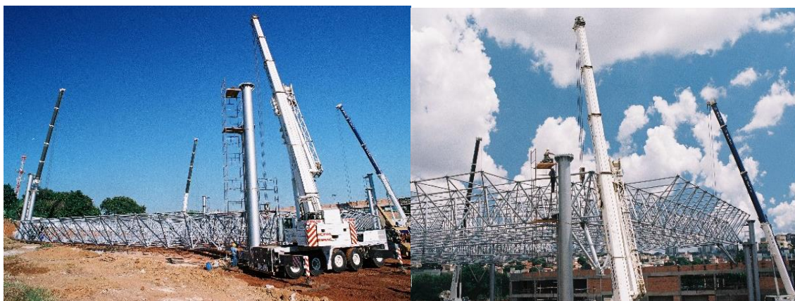
Figura 28: Fotos das Etapas do Método “lift-slab” - Expominas - Belo Horizonte - MG
