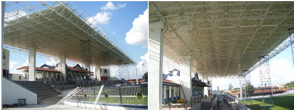
Figura 7: Fotos da Cobertura de ABCZ - Uberaba - MG Fonte: http://www.techneaco.com.br
