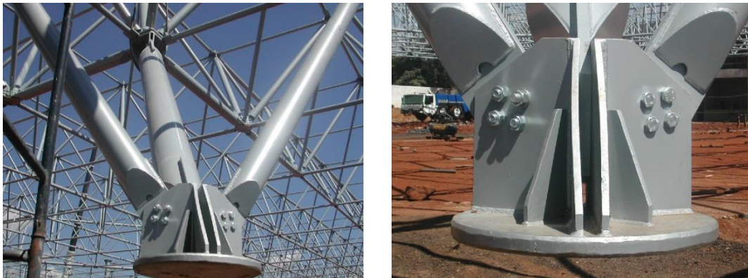
Figura 15: Detalhe do Nó de Aço - Expominas - Belo Horizonte - MG Fonte: http://www.techneaco.com.br
