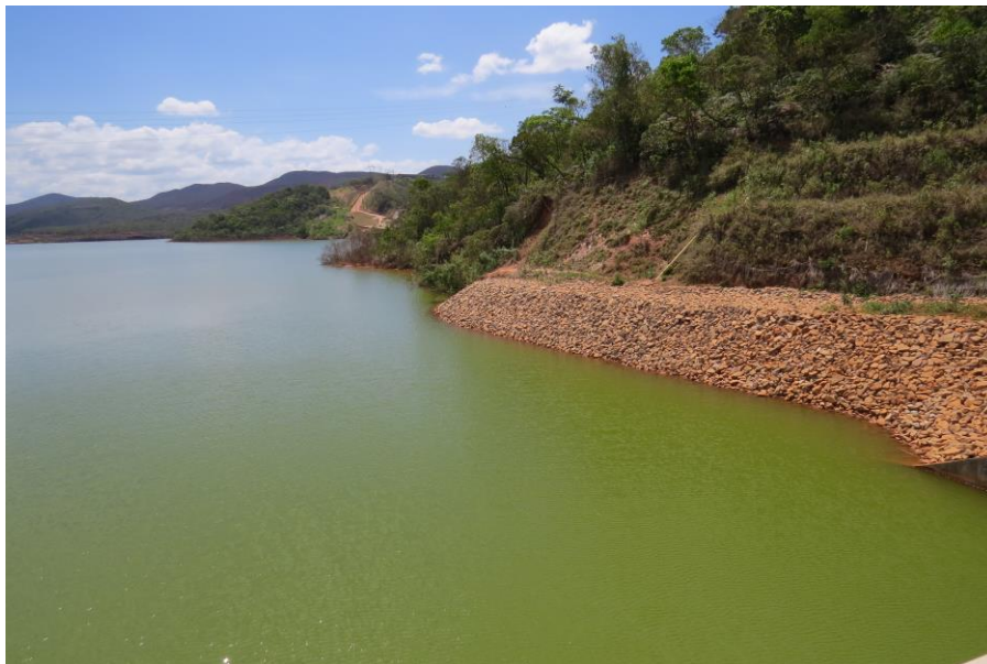
Figura 9 - Barragem de rejeitos da mina Brucutu em 04/11/2014
