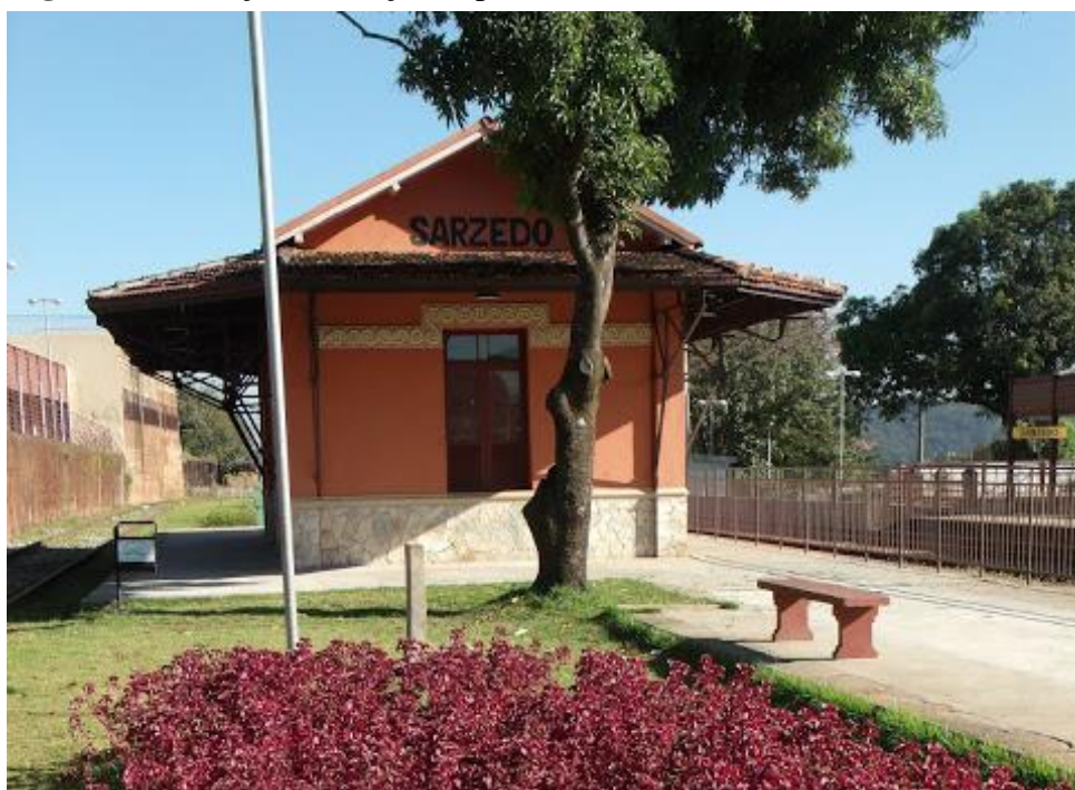
Figura 22 – Praça da Estação depois da reforma - 2008
