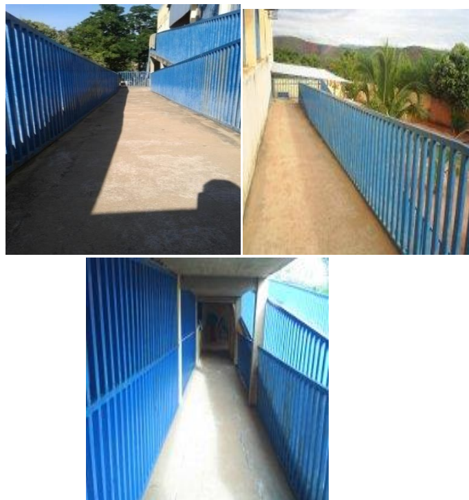
Fotos 133,134,135 -Rampa de acesso ao pátio
