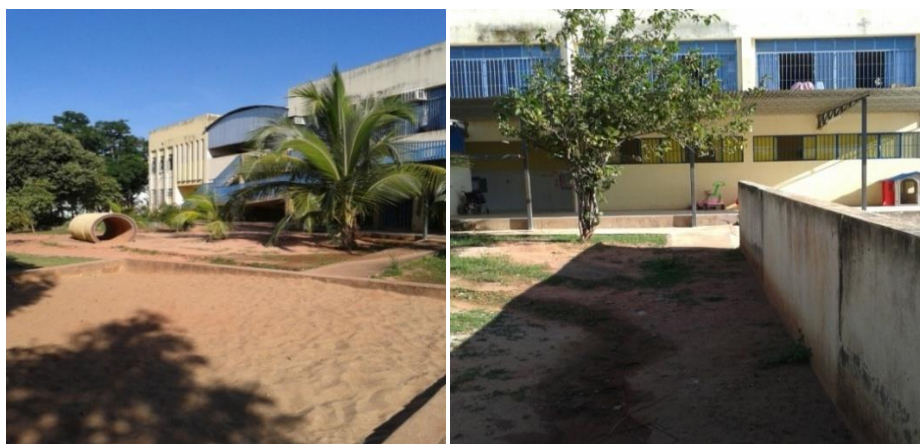
Fotos 146,147- Vista do pátio e do prédio, por outro ângulo.
