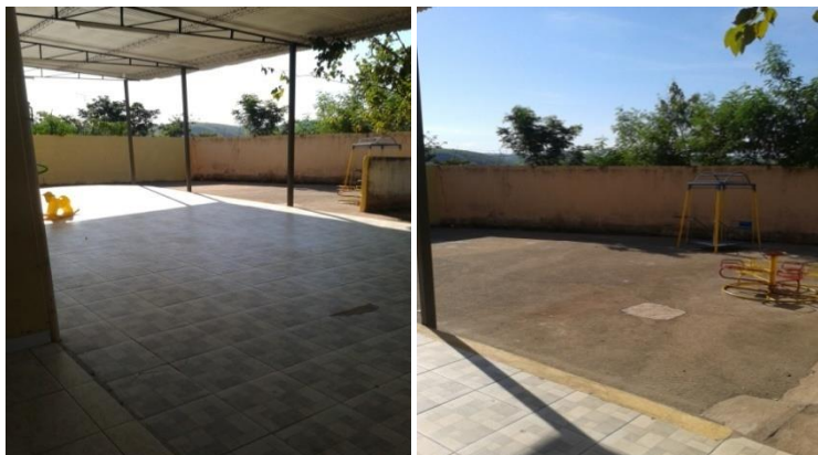
Fotos 152,153 -Pátio descoberto
