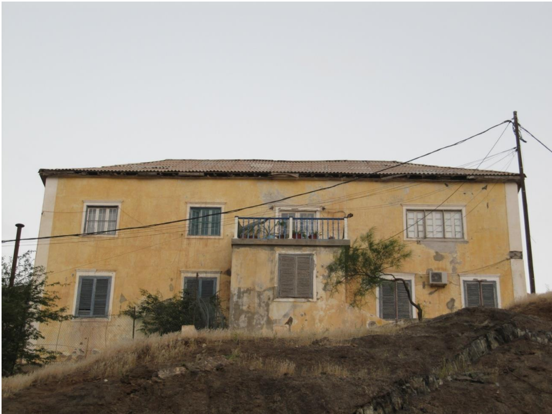
Figura 10 - Sede do Atelier Mar
