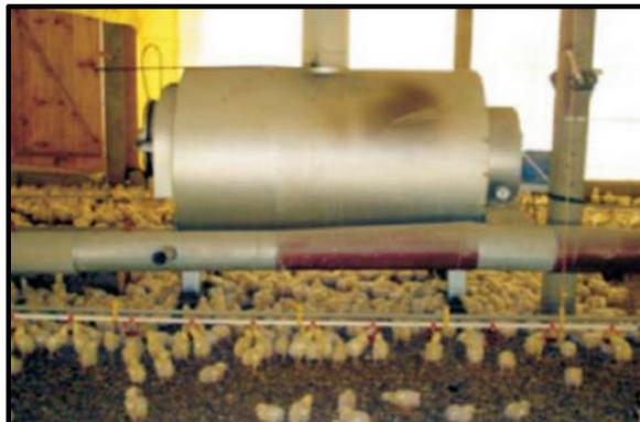
b) Fornalha a lenha com sistema de chaminé, ventilador e tubos distribuidores de ar quente
