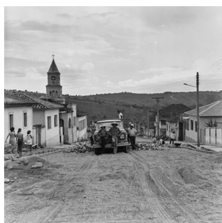
Figura 96: Arquivo 1975. Novembro I 75 I Dezembro. Calçamento Rua Mar. Deodoro. Dezembro 1975.
