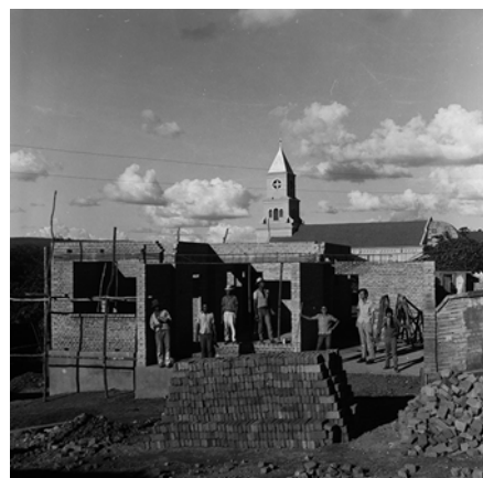
Figura 84: Arquivo 1972. Março I 72 I Abril. Construção (da casa de Antônio). Abril 1972.
