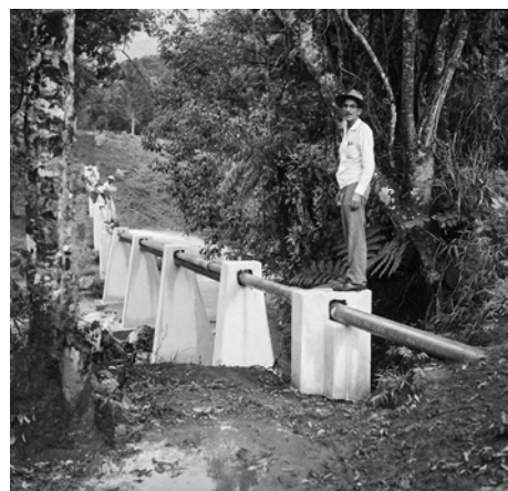
Figura 42: 1969-1970-1971. 02 I 00 I 02. Chegada Canos s/ Água Const. Rede Adutora.
