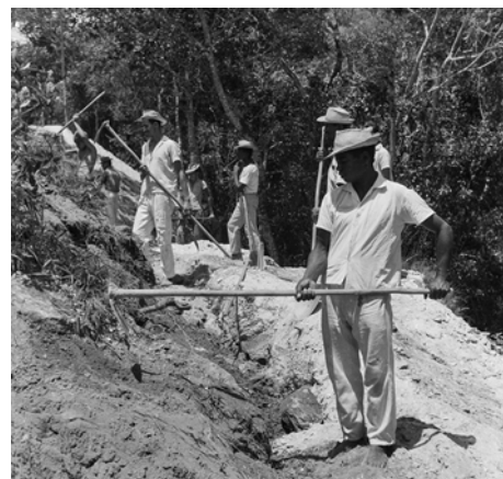
Figura 40: 1969-1970-1971. 02 I 00 I 02. Chegada Canos s/ Água Const. Rede Adutora.
