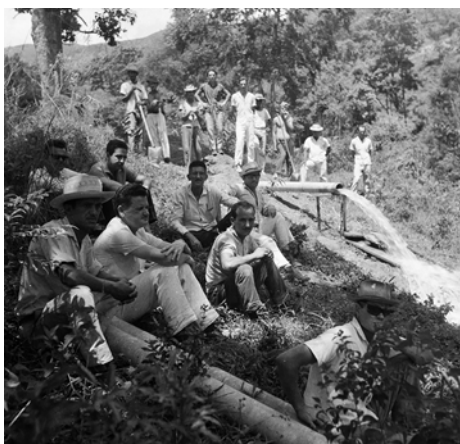
Figura 41: 1969-1970-1971. 02 I 00 I 02. Chegada Canos s/ Água Const. Rede Adutora.
