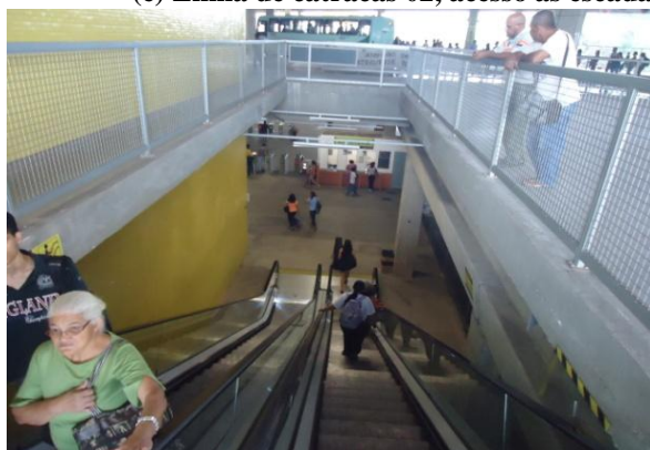
(g) Escadas rolantes 01 com bilheteria 01 (ao fundo)
