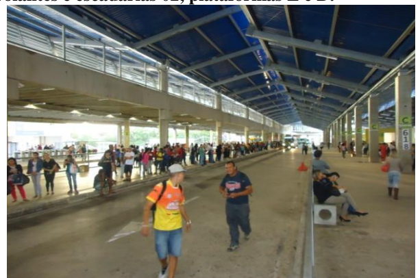
(h) Plataformas B e C com banco de concreto
