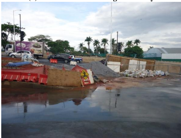
(c) Acesso Rua da Barragem (não operacional)
