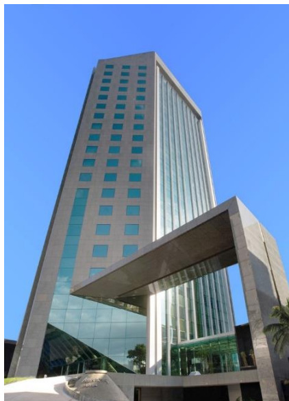
(a) Edifício totalmente condicionado
