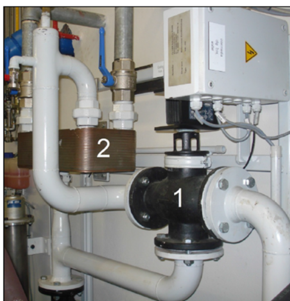
Figura 53 – Condicionador da água de arrefecimento do motor
