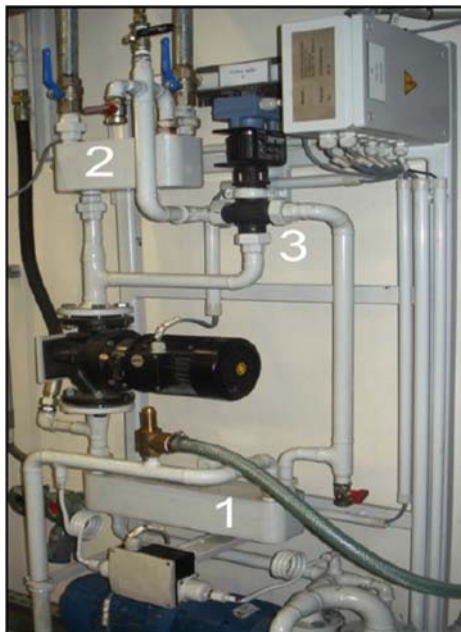
Figura 54 – Condicionador do óleo de lubrificação do motor
