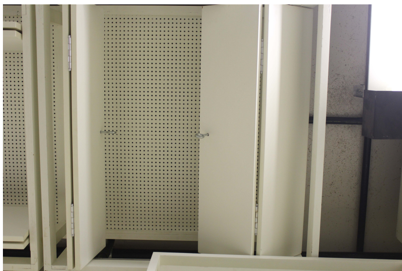
Figura 15 – Painel acústico de teto com suas aletas abertas.
