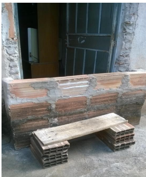
Figura 6 – Parede construída na entrada da residência para barrar água da chuva
