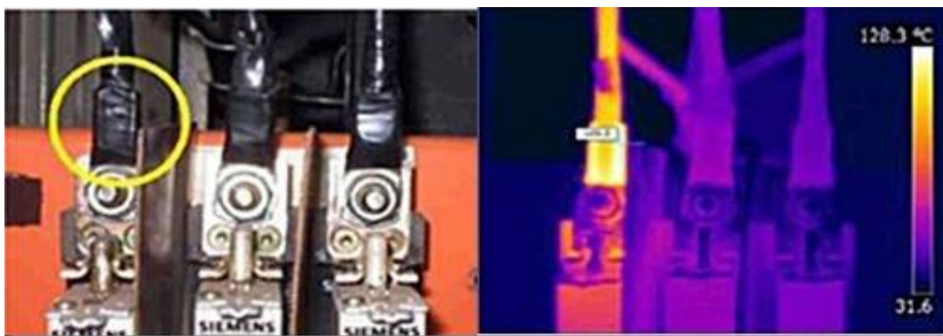
Figura 3.1 – Inspeção termográfica em terminais de fusíveis. Adaptado: (MARANTAR ENGENHARIA).
