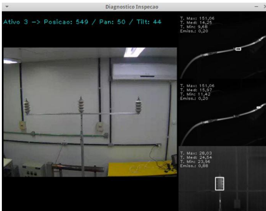
Figura 8.17 – Terceiro ponto da inspeção, focando no para-raios central.
