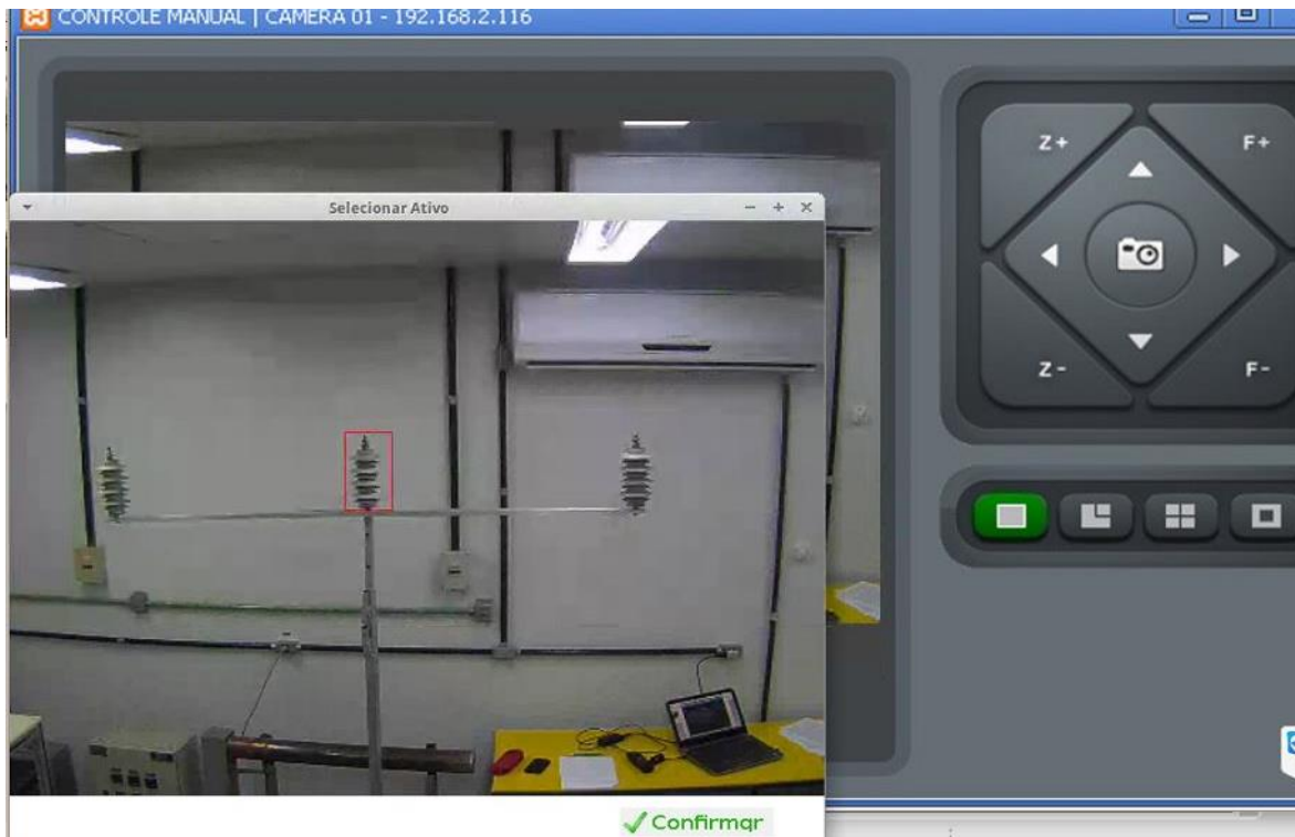
Figura 7.9 – Reconhecimento do ativo, com a área selecionada para obtenção das temperaturas.
