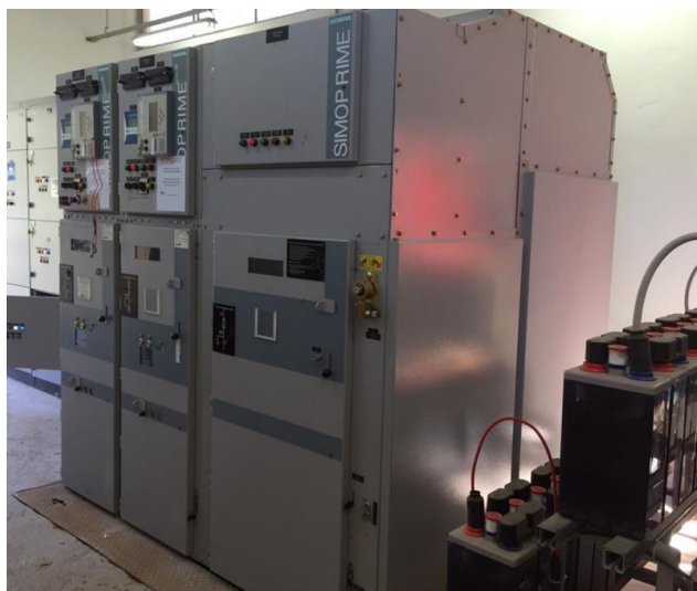
Figura 2.3 – Rack metálico de uma subestação abrigada. Adaptado: (GRUPO SANTIN).
