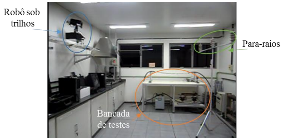
Figura 7.7 – Cenário montado no LabTerm para execução das inspeções. A esquerda o robô sobre os trilhos afixados na parede, com a bancada de testes de corrente ao fundo e os para-raios montados a esquerda.
