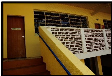
FIGURA 52: Escada de acesso ao terceiro andar e sala de atividades do Ensino Fundamental
